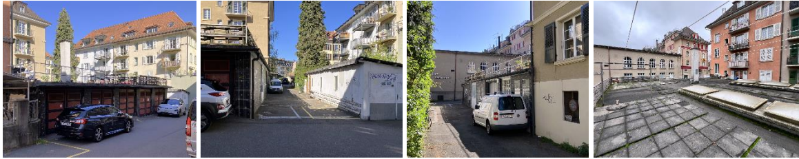
Außen: Garagenfront, Schopf mit Südfassade, Dachfläche mit Lichtkuppeln
